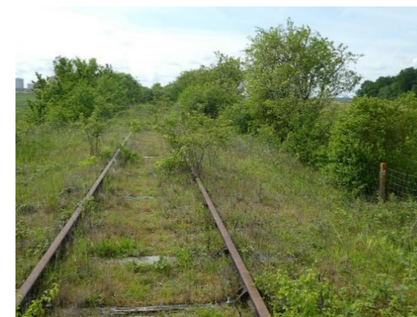
Figure 52 : Friche herbacée sur l'ancienne voie ferrée (in situ IEA)
